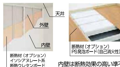
内壁は断熱効果の高い準不燃板、天井材は断熱効果に優れた素材を採用。
