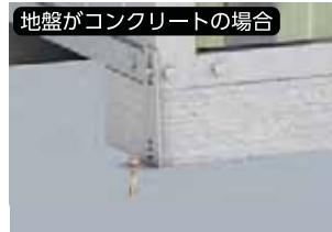
所定の大きさの穴を掘り、アンカープレートを取り付け、コンクリートを打設します。
